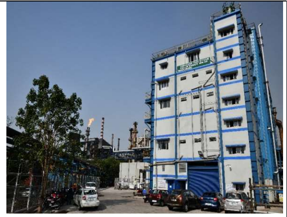
CDQ 40 MW Power Plant
