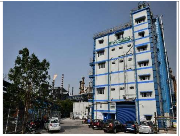
CDQ 40 MW Power Plant
