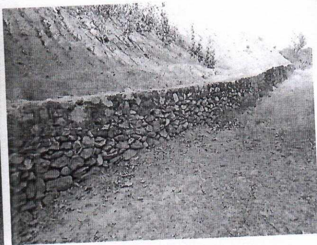
OB DUMP TOE WALL
